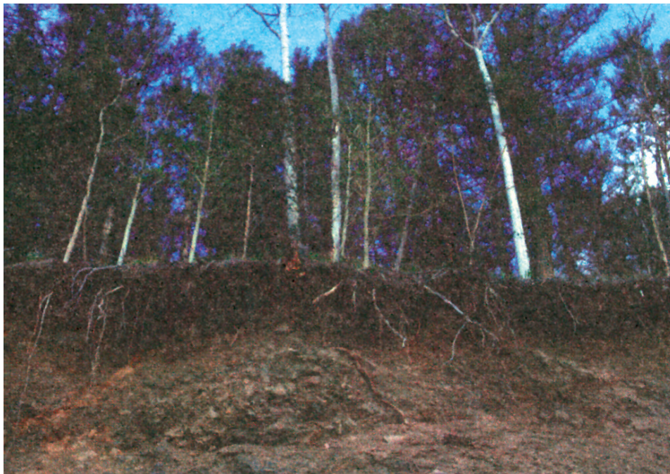
Εικόνα 6-3. Διάβρωση του εδάφους.
