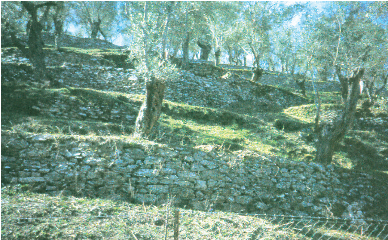
Εικόνα 4-18. Ελαιώνας σε αναβαθμίδες με τοίχο αντιστήριξης (ξηρολιθιά).
