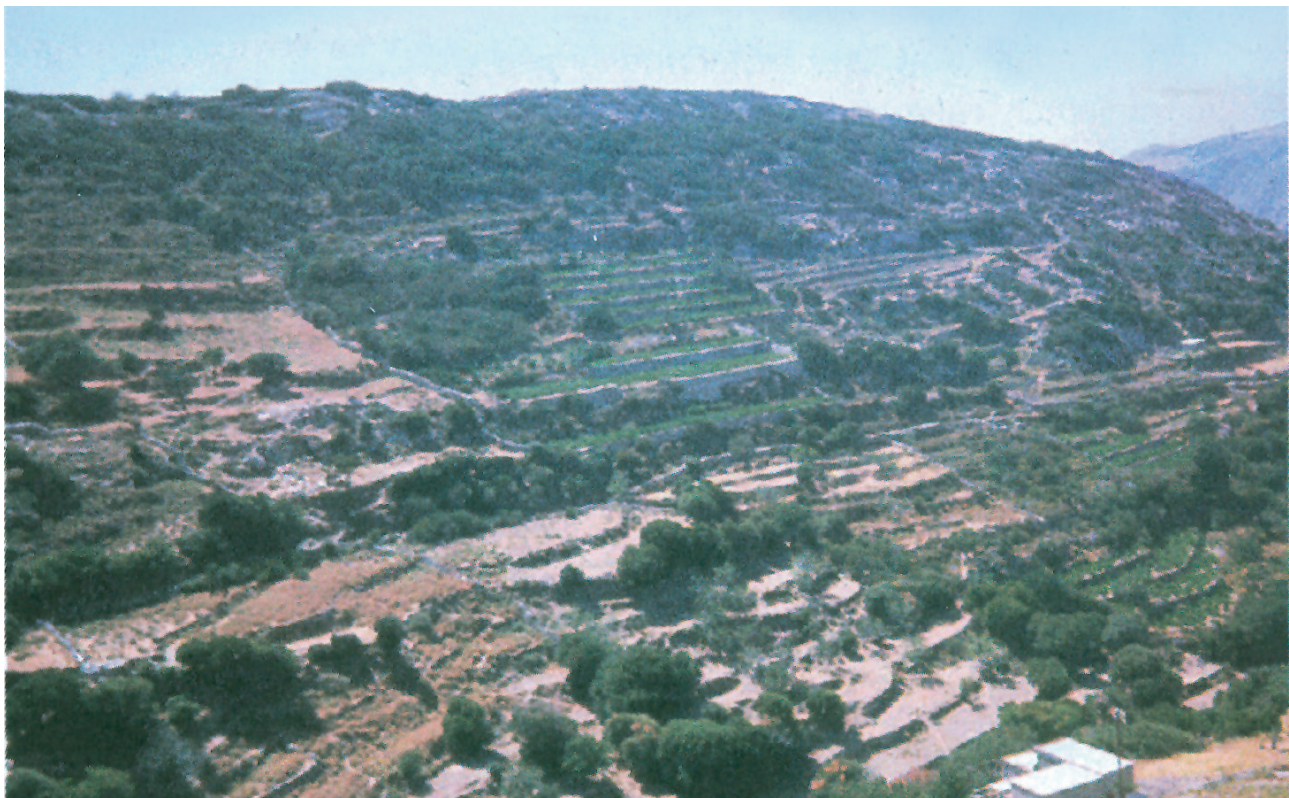
Εικόνα 4-19. Συνδυασμός αναβαθμίδων με τοίχους αντιστήριξης και επιχωματώσεις.
