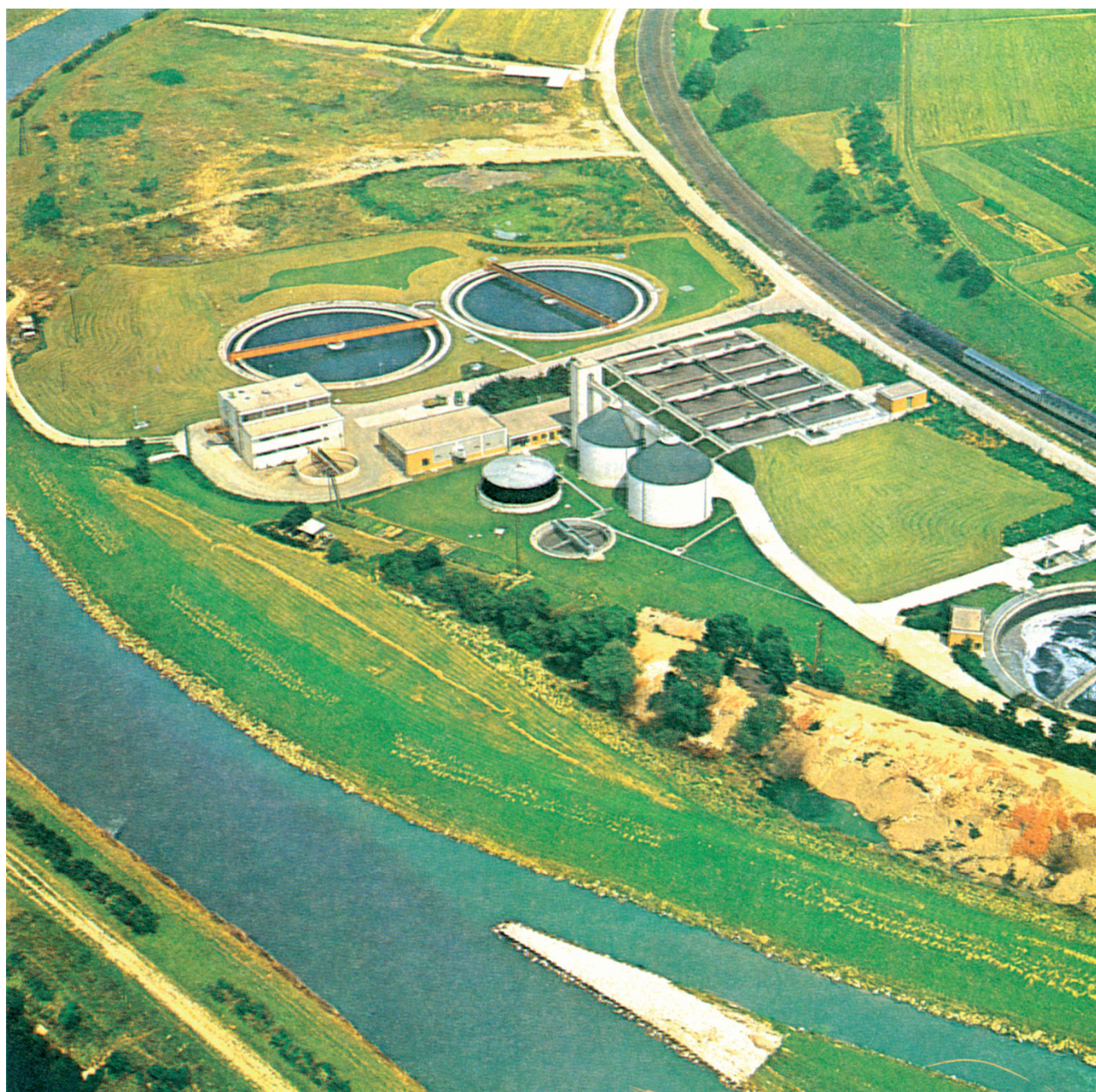
Εικόνα 10-3. Εγκαταστάσεις επεξεργασίας οικιακών λυμάτων στη πόλη Wendlingen (Γερμανία).
