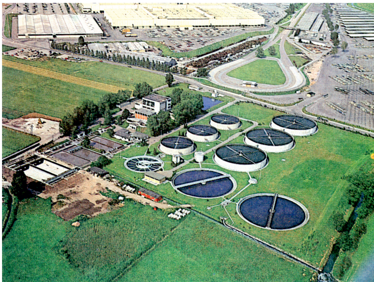
Εικόνα 10-2. Εγκαταστάσεις επεξεργασίας οικιακών λυμάτων και αποβλήτων της αυτοκινητοβιομηχανίας Daimler Benz στη πόλη Sindelfingen (Γερμανία).
