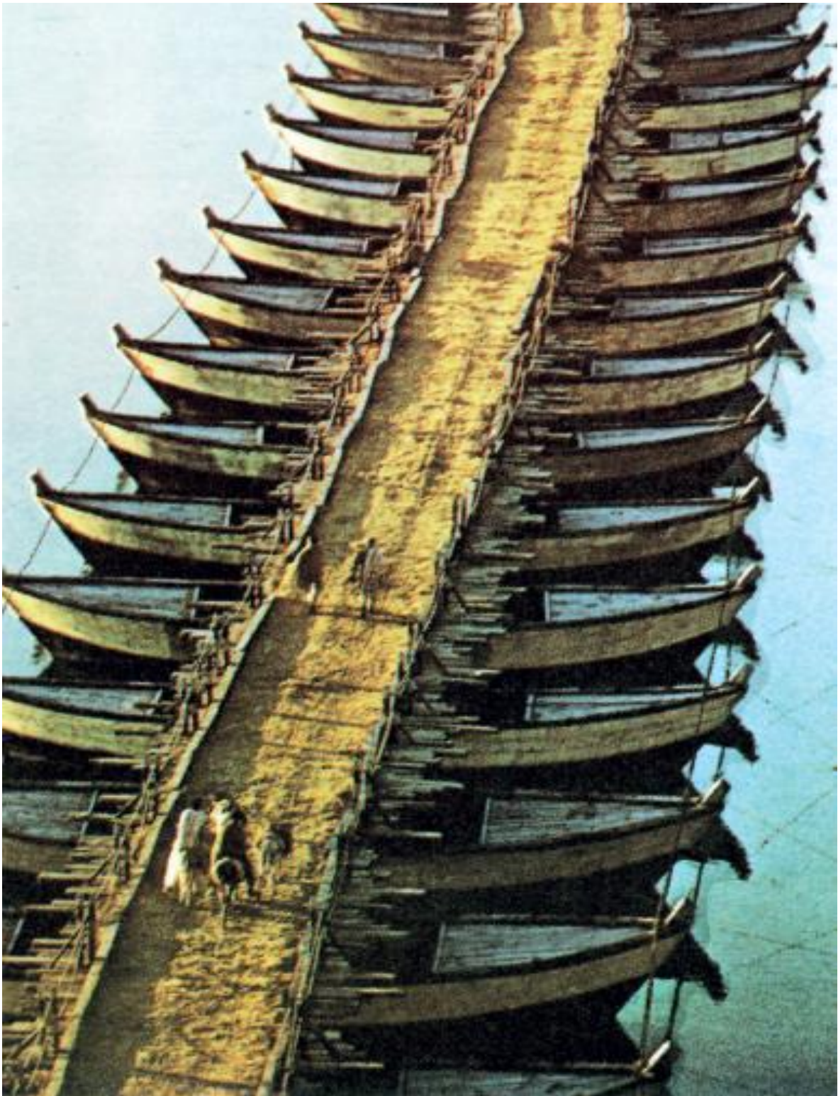
Λεμβόζευκτη γέφυρα του Κωφήνα.
