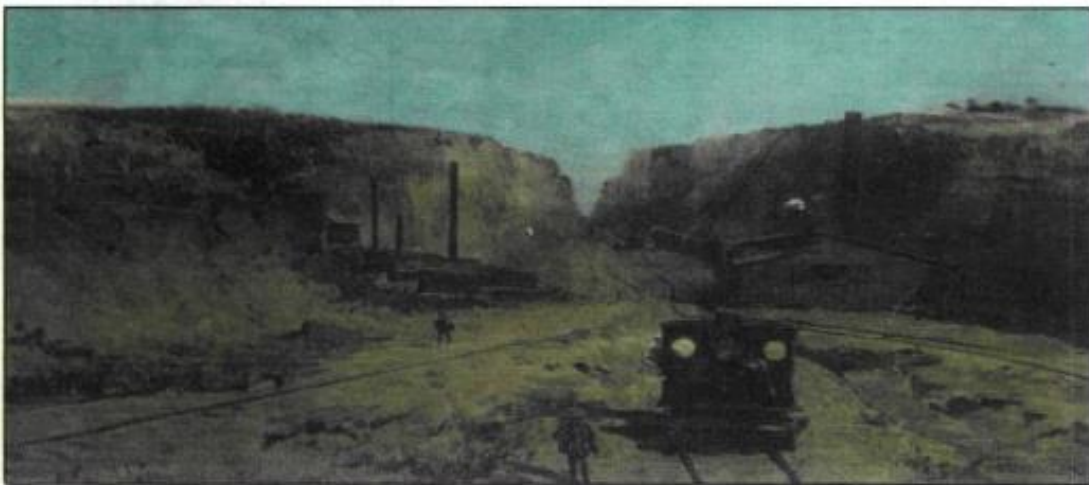
Η διάνοιξη της διώρυγας της Κορίνθου
