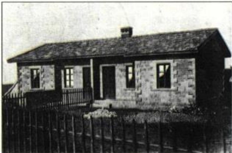
Διπλοκατοικία για εγκατάσταση αγροτών κατασκευασμένη από την ΕΑΠ
